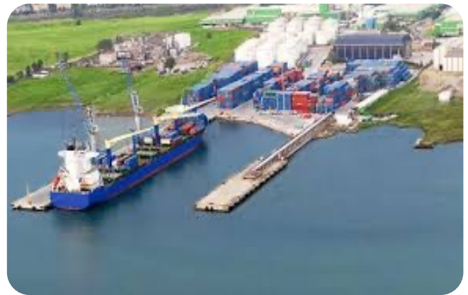
Parmak İskele Tipinde Sıvı Yük / Depolama Terminali
